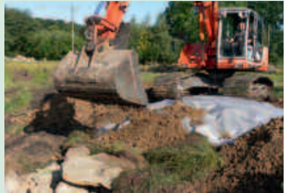
Winterquartier im Bau Hibernation quarter in construction
