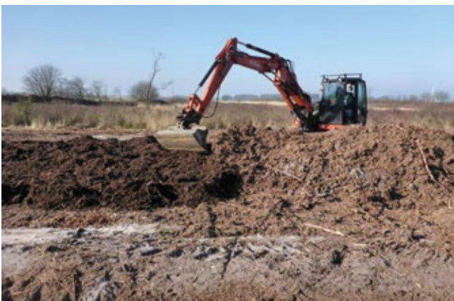
Abb. 83 & 84: Mit dem Forstmulcher durchgearbeitete Stubben- und Nadelstreu werden mit dem Bagger zusammengezogen und der alte Heideboden freigelegt (links, Foto C. Dolnik). Nach einem Jahr zeigen sich die ersten kleinen Heidepflanzen (rechts, Foto B. Rickert) neben raschwüchsigeren Gräsern.
