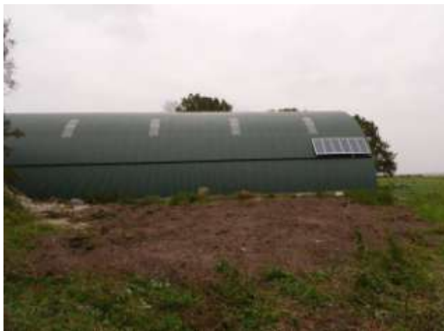
Lade med solceller til vandingspumpe
